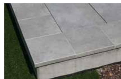
Vollkeramische Randeinfassung mit Stufen (siehe Bild) oder Längsschenkeln
